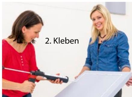
2. Tragen Sie den Kleber einseitig und wellenförmig auf den Untergrund der **xilent-Schallabsorber** auf. Verteilen Sie den Kleber gleichmäßig mit einem handelsüblichen Spachtel. Ein Verpressen des Klebers ist nicht nötig.
