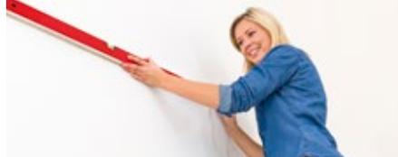
1. Mit einer Wasserwaage und unter Zuhilfenahme einer Schnur können Sie gerade Hilfslinien für die Schallschutzplatten einzeichnen.
