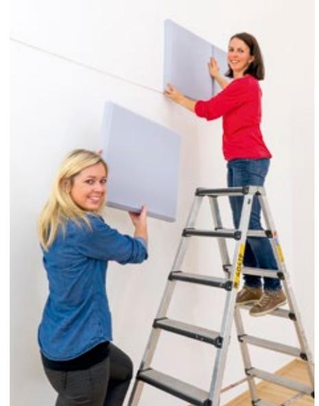
3. Bringen Sie die Schallabsorberplatte an der von Ihnen vorgesehenen Stelle (Decke oder Wand) an. Um die Platten gerade anzubringen, kann eine Schnur zur Hilfe genommen werden. Noch einige Minuten nach Anbringen der Platten ist eine Korrektur der Linienführung bei Bedarf möglich.
