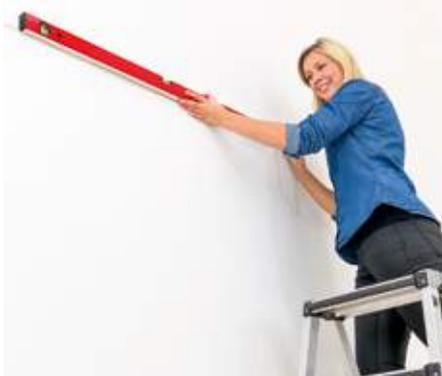
1. Mit einer Wasserwaage und unter Zuhilfenahme einer Schnur können Sie gerade Hilfslinien für die Schallschutzplatten einzeichnen.
